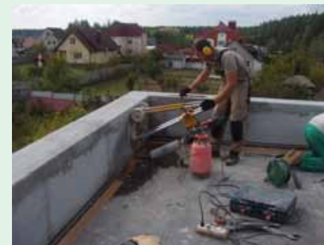
Вертикальные и горизонтальные гидроизолируемые поверхности предварительно отшлифовали
