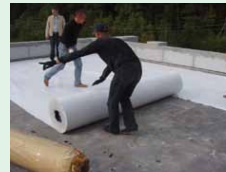
По всей поверхности кровли разстлали геотекстиль
