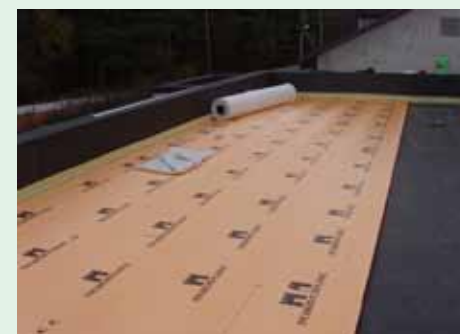
Гидроизоляция кровли и парапетов. Укладка жесткого утеплителя (экструдированный пенополистерол)
