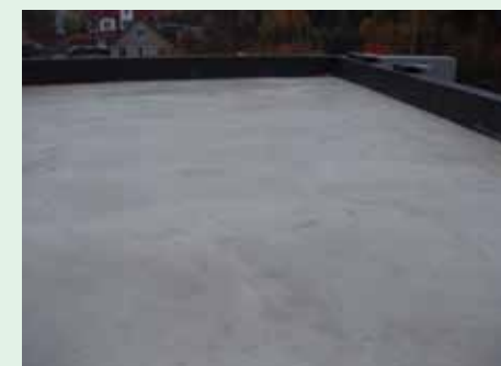
По всей территории инверсионной кровли сделали бетонную стяжку
