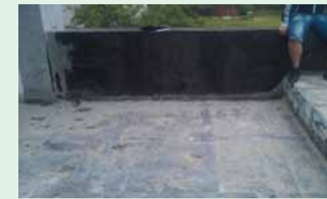
Старая битумная гидроизоляция прослужила недолго. Владелец дома принял решение отремонтировать кровлю с помощью гидроизоляционной мембраной EPDM. После несложных подготовительных мероприятий на плоской крыше закипела работа.
