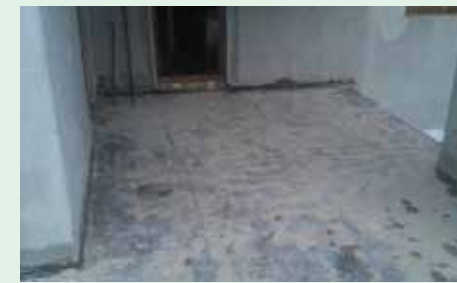
Старая битумная гидроизоляция прослужила недолго. Владелец дома принял решение отремонтировать кровлю с помощью гидроизоляционной мембраной EPDM. После несложных подготовительных мероприятий на плоской крыше закипела работа.
