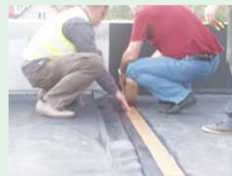
Система склейки швов на стыке двух полос мембраны
