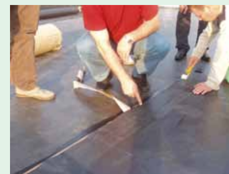
Со склейкой полотен справляется всего два работника
