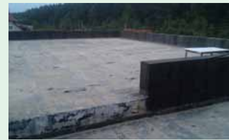
Старая битумная гидроизоляция прослужила недолго. Владелец дома принял решение отремонтировать кровлю с помощью гидроизоляционной мембраной EPDM. После несложных подготовительных мероприятий на плоской крыше закипела работа.
