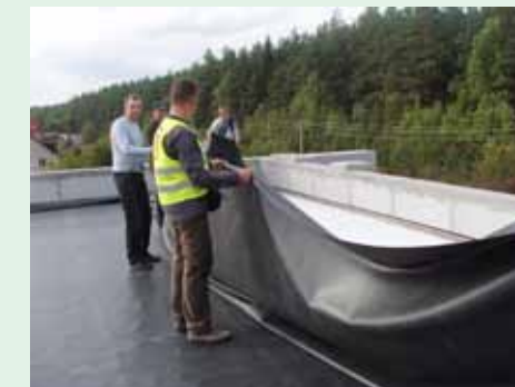
Большая ширина мембраны (6,1 м) позволила в рекордные сроки застелить огромную площадь кровли
