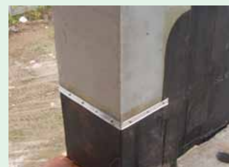
Вертикальная гидроизоляция прикреплена алюминиевой краевой полосой
